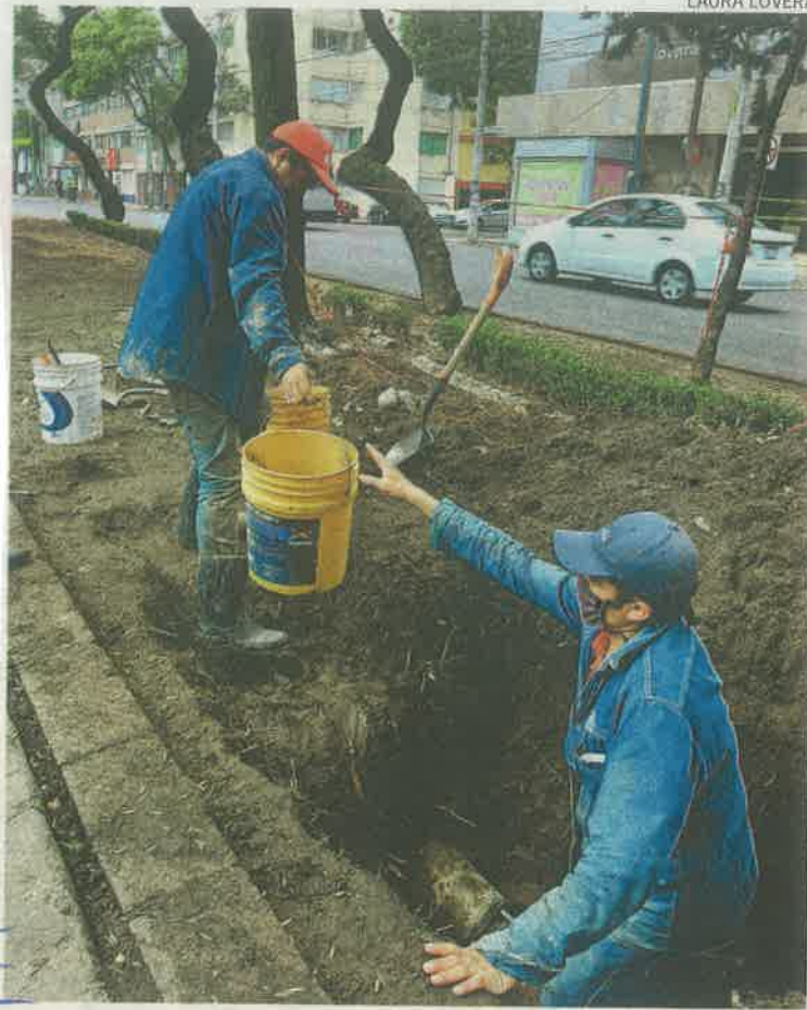
Trabajadores reparan una tubería rota en División del Norte
