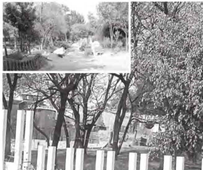
Los trabajos de demolición se realizaron antes de lanzar la licitación
