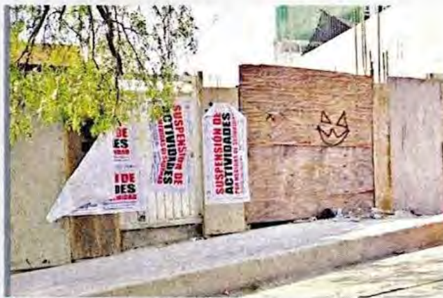
■ Los habitantes han señalado que existen al menos ocho obras fuera de norma en la zona.
