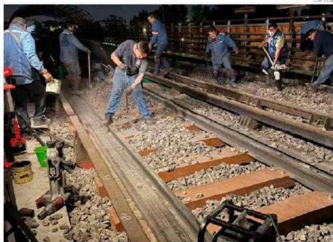
Los durmientes sintéticos serán colocados en el tramo Oceanía-Deportivo Oceanía.
