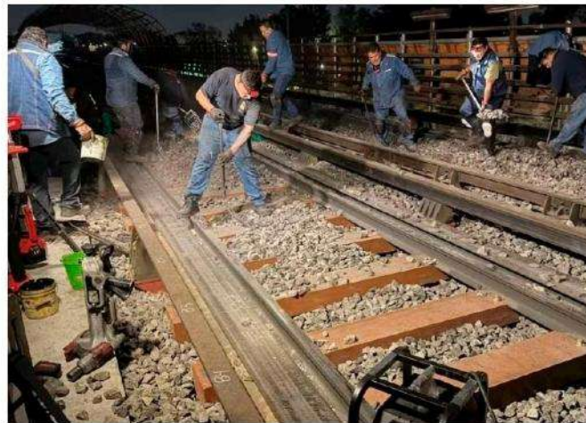
Los durmientes sintéticos serán colocados en el tramo Oceanía-Deportivo Oceanía.
