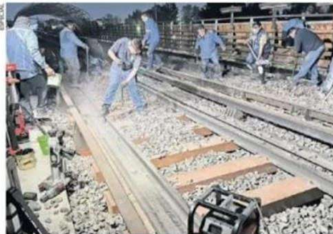
Personal del área de Instalaciones Fijas del Metro, especializado en mantenimiento a vías, realiza la instalación de durmientes.
