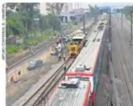
En inmediaciones de la estación Lechería se observó a ingenieros revisando vías y durmientes.
