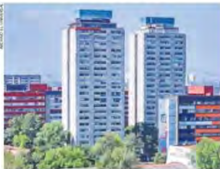
De acuerdo con los primeros estudios realizados por el Gobierno capitalino, el edificio 5 de febrero tiene daños menores.
