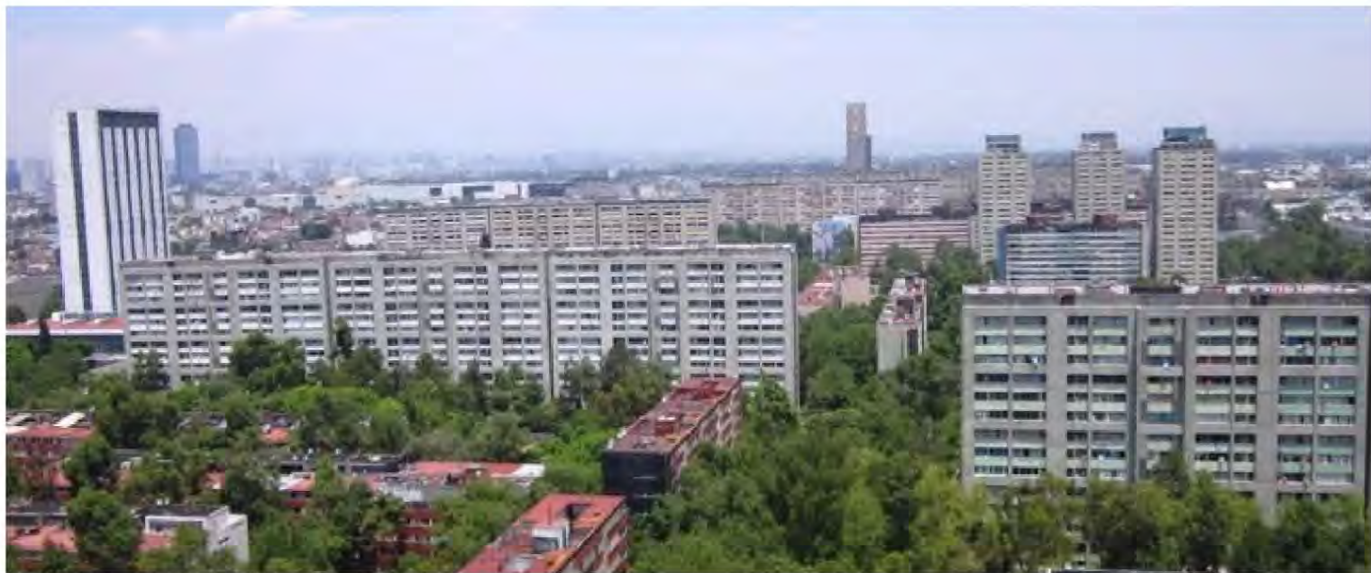
Detectan 27 edificios, de 90, en Tlatelolco con daños estructurales.
