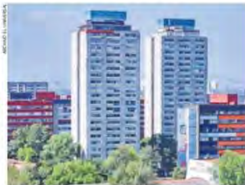
De acuerdo con los primeros estudios realizados por el Gobierno capitalino, el edificio 5 de febrero tiene daños menores.
