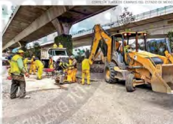
La primera etapa de rehabilitación comenzó esta semana en el tramo de Naucalpan con dirección a Tepotzotlán
