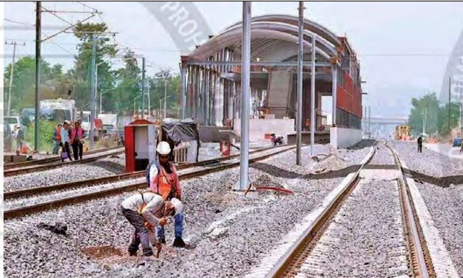
Aseguran residentes que los trabajos de construcción también han afectado negocios; los comerciantes se quejan por el desplome de ventas de hasta 50 por ciento
