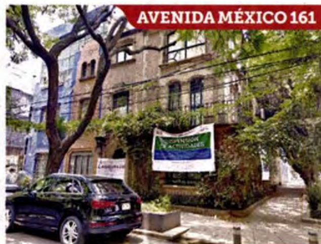
■ Frente al Parque México trabajos de demolición sí fueron detenidos.
