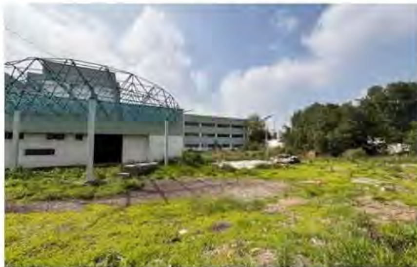
Hospital Ceylán en Tlalnepantla, Estado de México.
