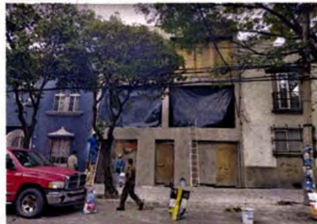
■ Una obra al interior de un inmueble de la Condesa ha avanzado pese a estar identificada como irregular.
