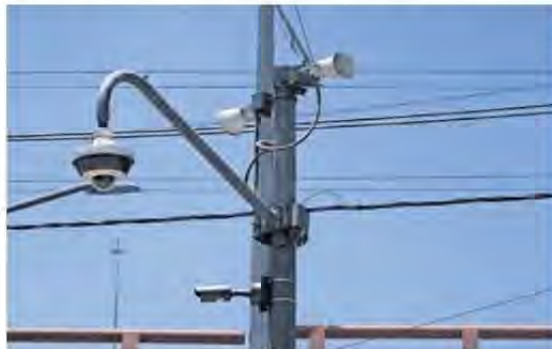
Los tótems son postes que cuentan con cámaras, altavoz y botón de pánico y están enlazados al C5 para enviar una alerta en tiempo real.
