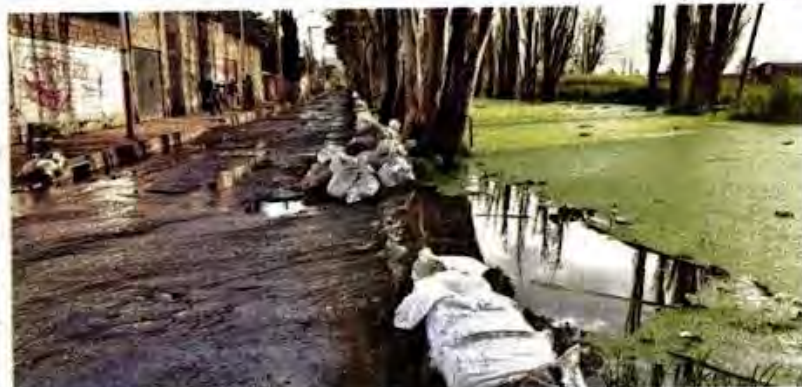
Efectivos de Defensa colocaron sacos terreros para tratar de contener el desbordamiento.
