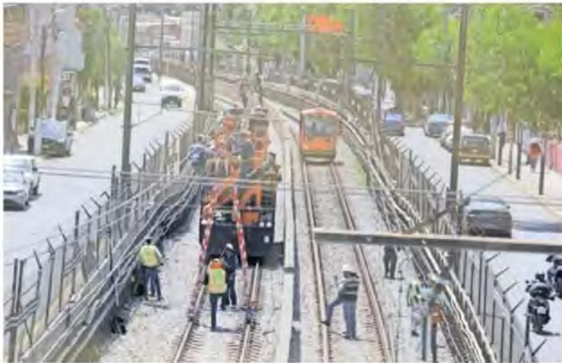
Durante la noche del lunes y el martes, personal del Metro se encargó de reinstalar la catenaria entre las estaciones Los Reyes y La Paz. Mientras, la Línea A operó de Pantitlán a Santa Marta. A las 19:50 horas de ayer el tramo intervenido se abrió al público.
