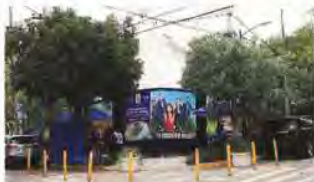
El inmueble se encuentra cubierto con tapiales, que exhiben diversas publicidades.
