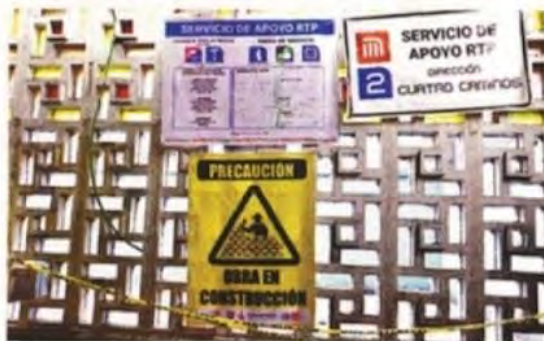
■ Sólo una lona y una cinta que delimita el espacio advierten a los usuarios del Metro de la realización de la obra.
