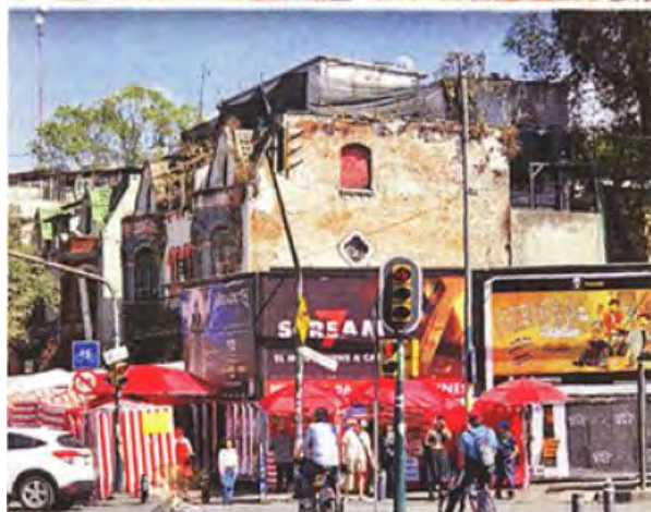
Desde la calle son visibles las obras y los trabajadores, pero no la Manifestación de Construcción.
