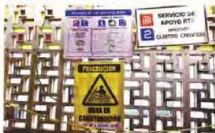
Sólo una lona y una cinta que delimita el espacio advierten a los usuarios del Metro de la realización de la obra.
