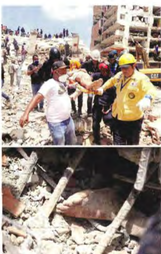
Cientos de edificios colapsaron en Venezuela y la población denuncia la ausencia del Gobierno en las labores de rescate.
