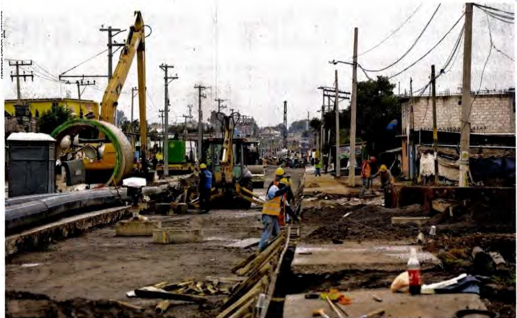
En la avenida Solidaridad se realizan trabajos para cerrar las zanjas por donde pasa tubería del nuevo colector, que se puso en operación hace unos días.
