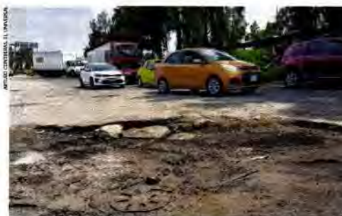
A partir del 30 de junio se tiene previsto comenzar con el bacheo profundo de 22 kilómetros de carriles centrales y 32 kilómetros de laterales de Periférico Norte.
