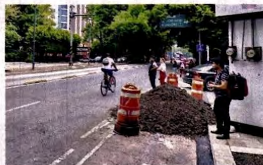
■ Las obras de la Sobse se realizan sobre Insurgentes, en el tramo de Circuito Interior Río Mixcoac hasta el Viaducto.
