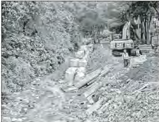
▲ Enormes costales con arena y grava contienen el potencial deslizamiento en la colonia El Pirú. Foto Jalir Cabrera Torres
