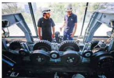
Como parte de los trabajos de este año se desmontaron seis torres para inspeccionar rodillos, poleas y balancines.
