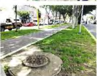
Autoridades reemplazaron parte de un ducto que se encuentra en Avenida 604, donde fue localizada una toma.
