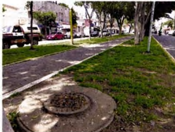
■ Autoridades reemplazaron parte de un ducto que se encuentra en Avenida 604, donde fue localizada una toma.
