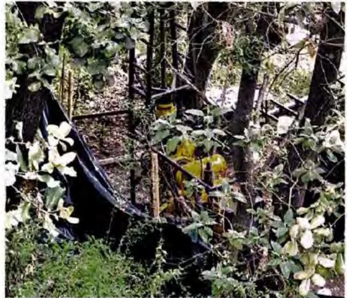
■ Pese a la declaratoria que protege a la Barranca, se realizan perforaciones para edificar la estación Oasis de la L-5.
