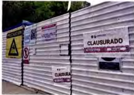
La Sedema colocó sellos de suspensión al predio y así se mantendrá en tanto se evalúa el daño al arbolado.
