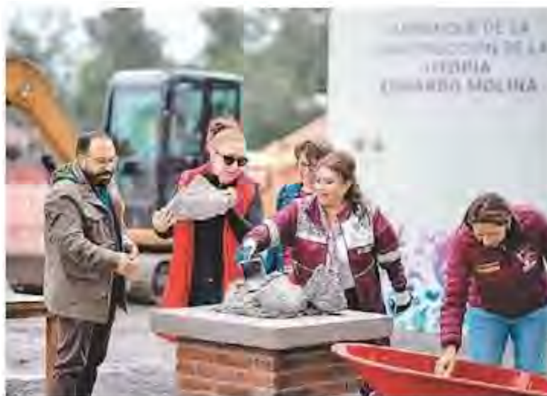
Banderazo a construcción de Utopía Eduardo Molina. ESPECIAL
