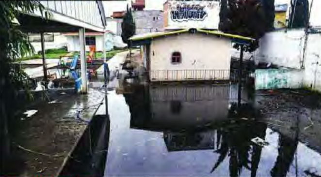
HUNDIMIENTOS AGRAVADOS. Desde el año pasado las anegaciones en el plantel se han dramatizado, a tal punto de tener que detener clases por hasta dos meses.
