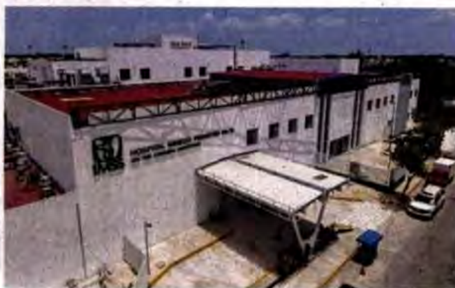
■ La Presidenta visitó el domingo las obras del hospital Gineco-Pediátrico de Ciudad del Carmen, Campeche.
