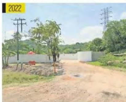
En mayo de ese año se retira el alambre de púas y las láminas que son sustituidas por una barda de cemento.
