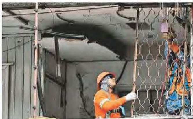
Demolición de edificación. JAVIER RÍOS
