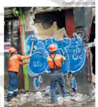
Demolición del edificio, en la calle de Fray Servando 172 y 174.
