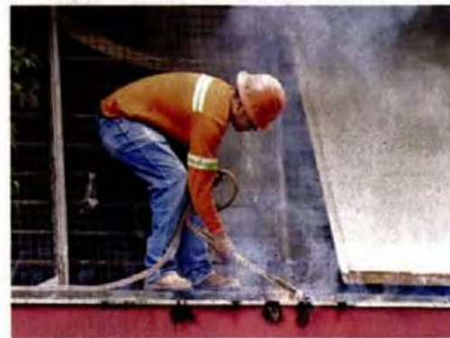
■ A través de la demolición de los inmuebles afectados, el Gobierno busca mitigar el riesgo latente.
