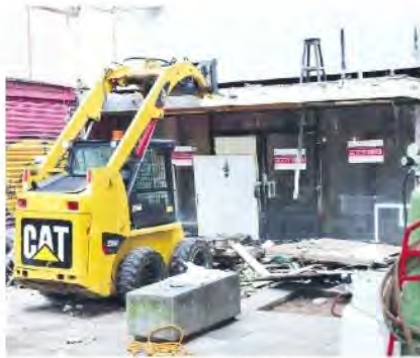
La demolición inicial costará 7 mdp
