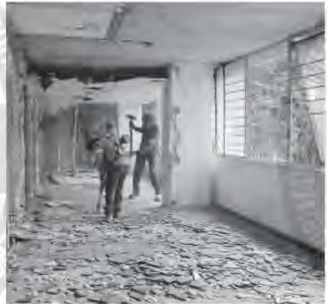
Los trabajos de demolición en los inmuebles iniciaron el lunes.
