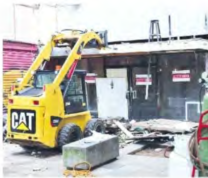
La demolición inicial costará 7 mdp
