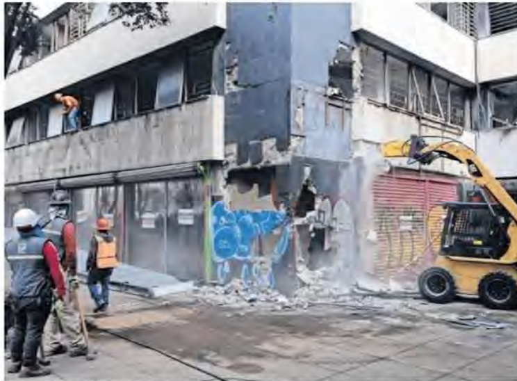
Este lunes inició la demolición de dos edificios ubicados en Fray Servando 172 y 174; los trabajos estarán supervisados por la Comisión para la Reconstrucción y el Instituto de Seguridad para las Construcciones.
