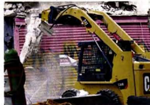
■ Los trabajos que iniciaron en Fray Servando requirieron un gasto de 7 millones de pesos.
