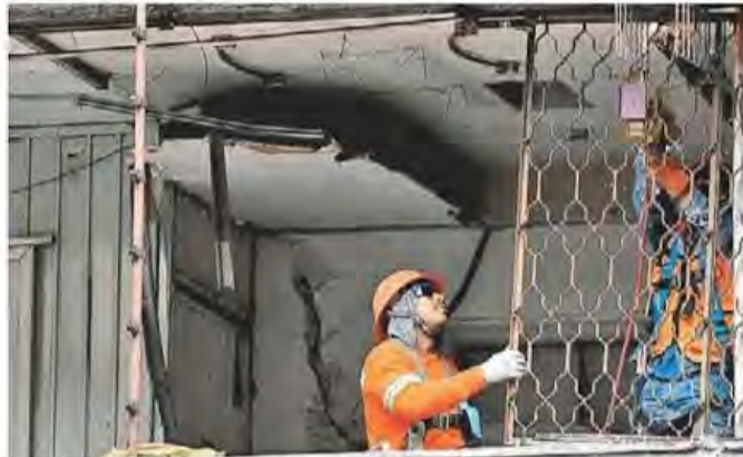
Demolición de edificación. JAVIER RÍOS
