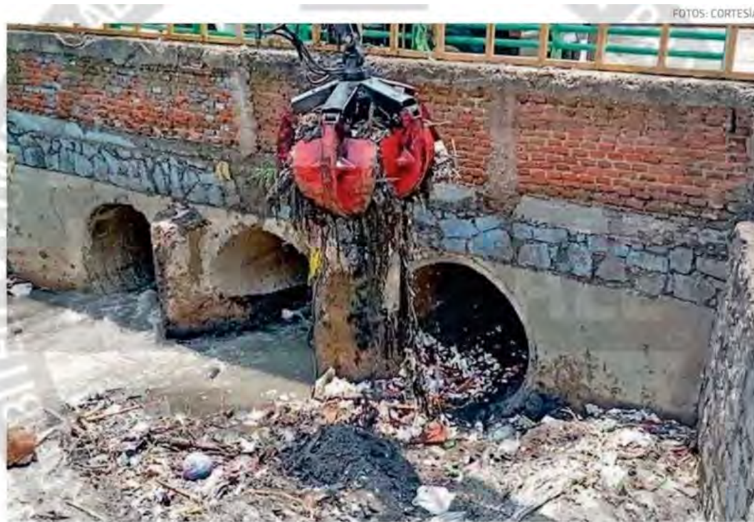
La Segiagua y la alcaldía Álvaro Obregón desazolvan con una retroexcavadora
