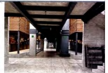
EN ESTAS áreas se siguen realizando trabajos en el recinto.
