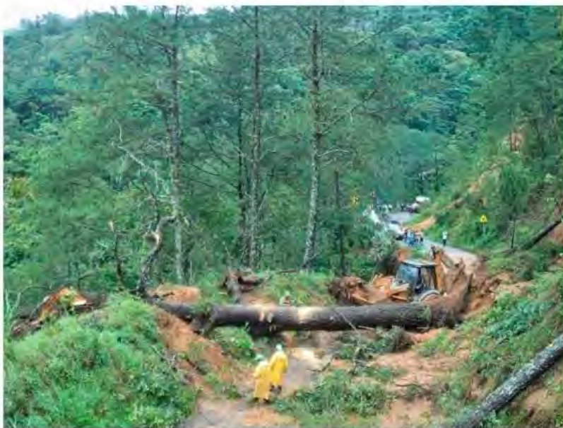
SICT libera la circulación de carreteras federales afectadas por el huracán Erick .
