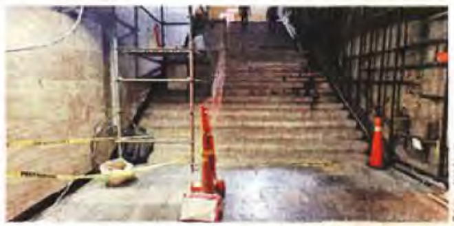
■ En Hidalgo, las escaleras lucen trabajos en desarrollo.
