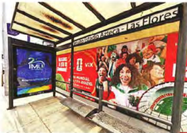
■ También se han instalado estructuras metálicas para soportar anuncios.
