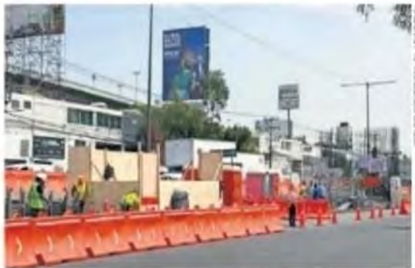
Las obras iniciaron en la avenida Gustavo Baz, en dirección a Cuautitlán Izcalli, a la altura de Tequexquahuac.
