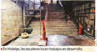
En Hidalgo, las escaleras lucen trabajos en desarrollo.
