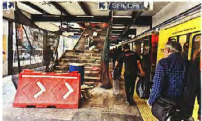
■ En la estación Viaducto de la Línea 2, usuarios conviven entre las obras que se realizan en el andén.
