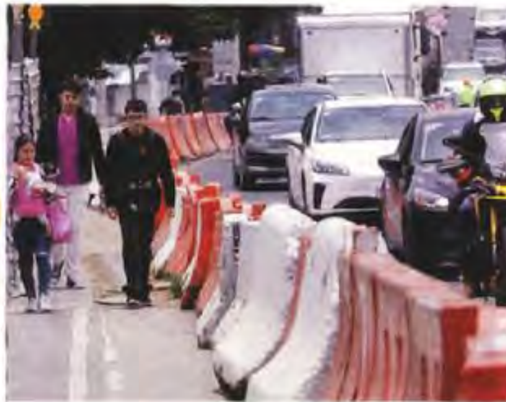
■ Peatones deben sortear el tráfico, debido a que algunas zonas se encuentran obstruidas por las obras.
