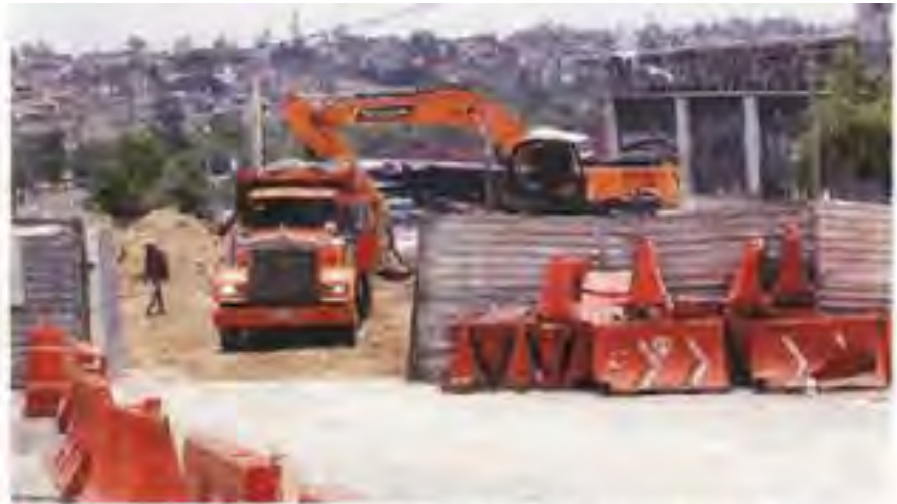
■ Las obras son delimitadas por paredes improvisadas con láminas de metal, que impiden el paso.
