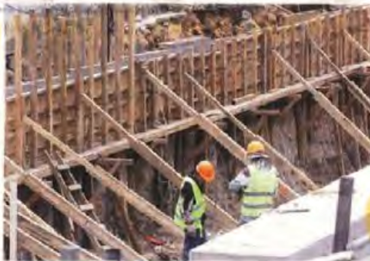
■ Trabajadores señalan que la conclusión de los pasos que conectan con el Hospital tardarán un año más.
