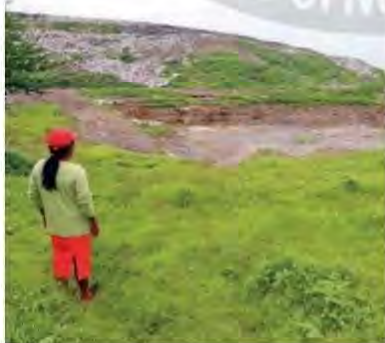
Los habitantes están enojados de que las autoridades no cierren el relleno sanitario
