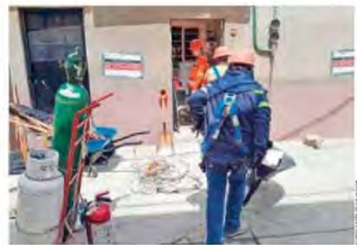
OBRAS. La remodelación y construcción de viviendas dañadas por los sismos del 2017, sigue de forma continua.
