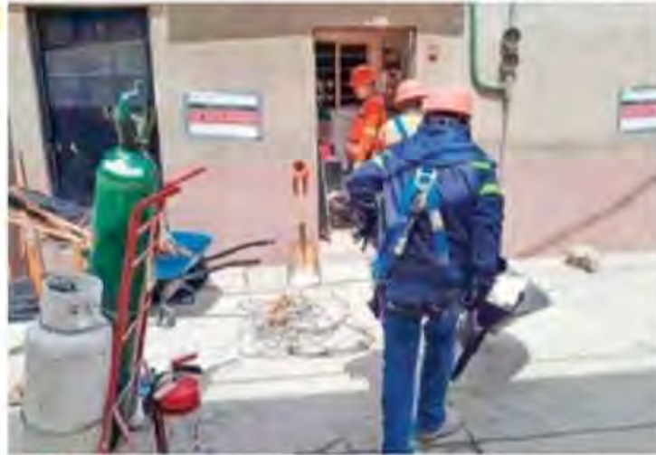
OBRAS. La remodelación y construcción de viviendas dañadas por los sismos del 2017, siguen de forma continua.
