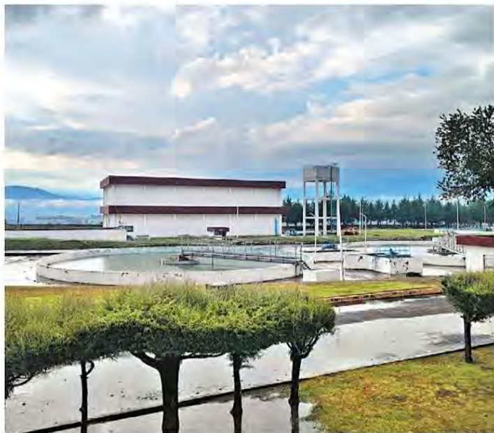
Recorrido por el complejo ubicado en San José Villa de Allende. FANNY MIRANDA
