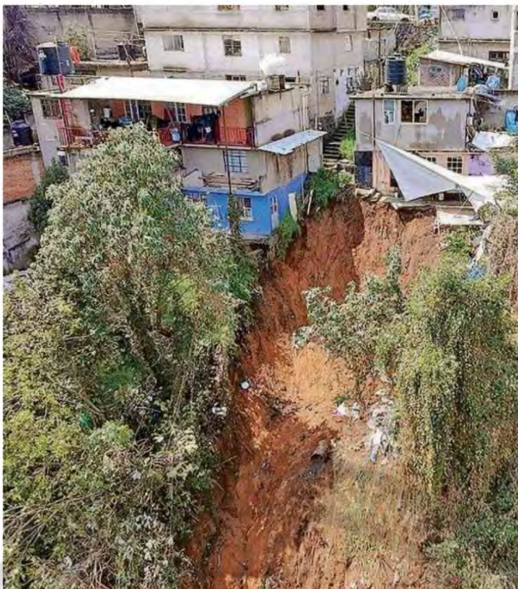
El desmoronamiento se llevó árboles y tuberías que estuvieron a su paso; en La Magdalena Contreras se activó alerta roja
