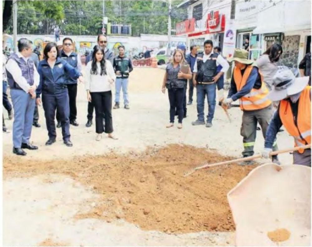
El alcalde de Coyoacán supervisó los trabajos que se realizan en las inmediaciones del Estadio Azteca con miras al Mundial.
