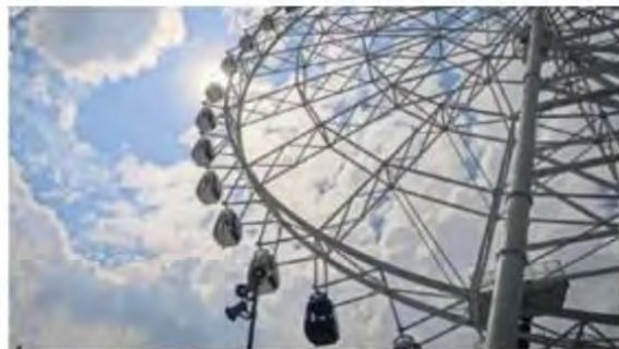
En julio de 2021 se pusieron en marcha las obras del parque Aztlán, que fue inaugurado en marzo de 2024.
