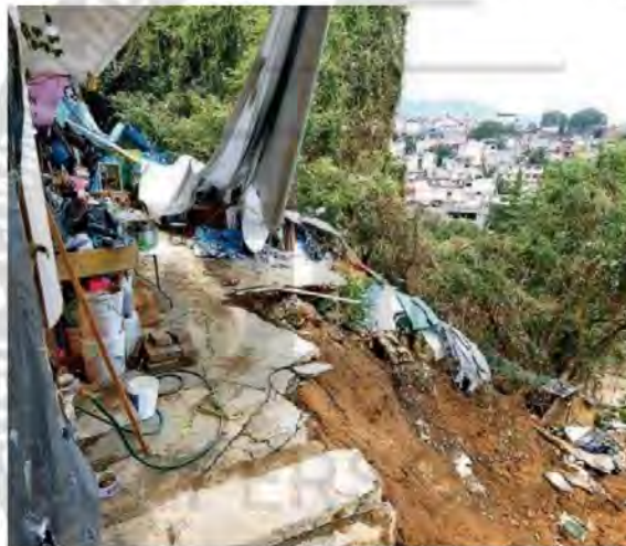
De un momento a otro el cerro se desgajó, ya que el muro de contención se había derribado
