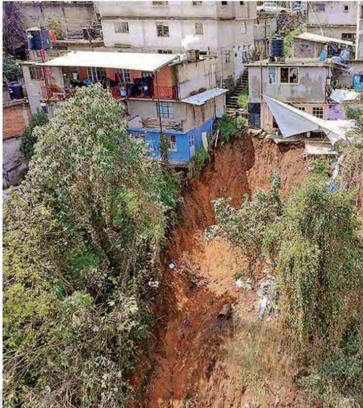
El desmoronamiento se llevó árboles y tuberías que estuvieron a su paso; en La Magdalena Contreras se activó alerta roja
