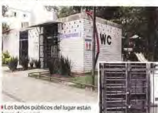
Los baños públicos del lugar están fuera de servicio.
