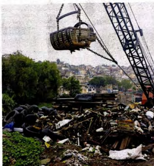
■ Maquinaria fue empleada para la remoción de residuos, entre llantas, bolsas y muebles.
