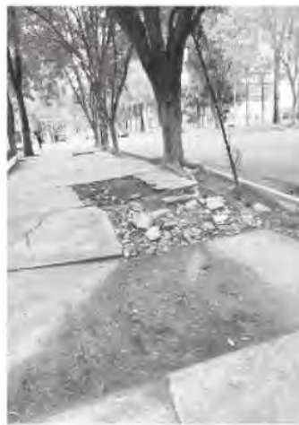
El pavimento está pandeado y con deformaciones
