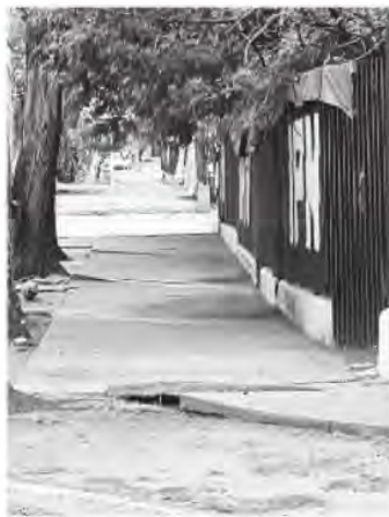
El pavimento está pandeado y con deformaciones
