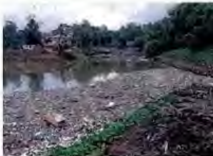
A los vecinos les preocupa que por la cantidad de basura se desborde la presa Río Becerra.
