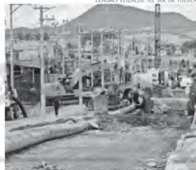
Las obras en avenida Solidaridad continúan
