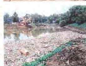
A los vecinos les preocupa que por la cantidad de basura se desborde la presa Río Becerra.
