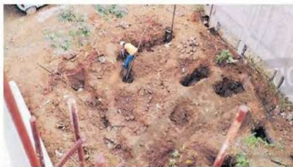
Excavaciones al lado de las viviendas.
