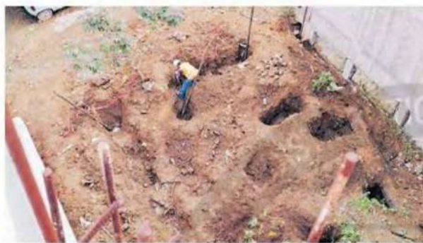
Excavaciones al lado de las viviendas.
