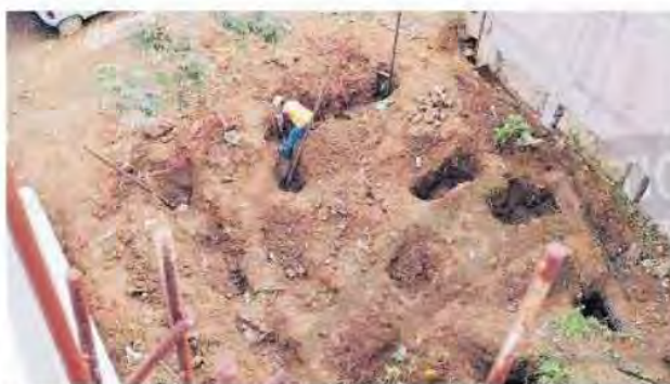
Excavaciones al lado de las viviendas.
