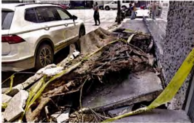
De nada sirven las cintas para delimitar la zona. Las raíces de un árbol y bloques de concreto imposibilitan por completo el paso en la banqueta ubicada sobre Calle 15.
