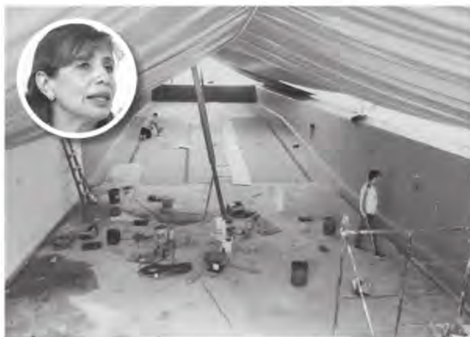
La obra arrancó el 28 de abril del año 2022
