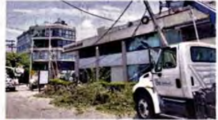
Consecuencia de las lluvias, un árbol ubicado sobre la Calle San Lorenzo cayó y provocó la inclinación de un poste.
