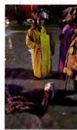
Personal de Bomberos trabajan en el desazolve de una coladera.
