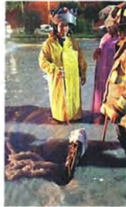
Personal de Bomberos trabajan en el desahucio de una coladera.
