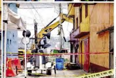
LOS TRABAJOS. Con maquinaria comenzaron las labores de demolición controlada de cuatro inmuebles afectados.
