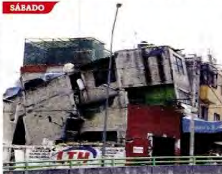
■ Las labores incluyeron a personal especializado con el fin de reducir riesgos a los otros predios en la zona aledaña.
