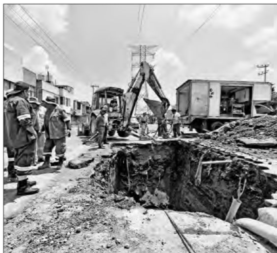
◀ La ruptura de un tubo de drenaje con medio siglo de antigüedad provocó que entre las calles 21 y 22 de la colonia José López Portillo se abriera un enorme socavón. Foto Mara Ximena Pérez
