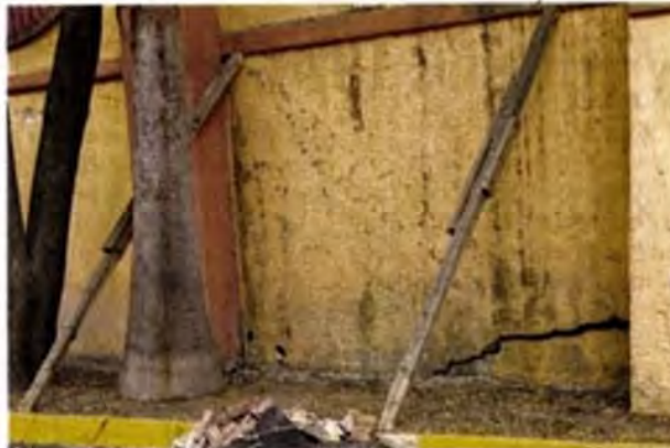
■ Vigas de hasta 2 metros de largo son colocadas para dar soporte a una parte del muro que presenta inclinación.
