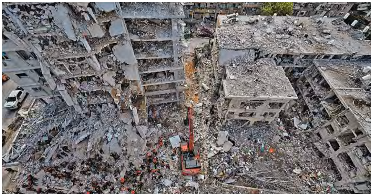
Edificios residenciales en Tel Aviv reducidos a escombros tras ataques comandados desde Teherán. AP
