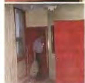
Aseguran que desde 2017 se han acumulado casos similares en el edificio.
