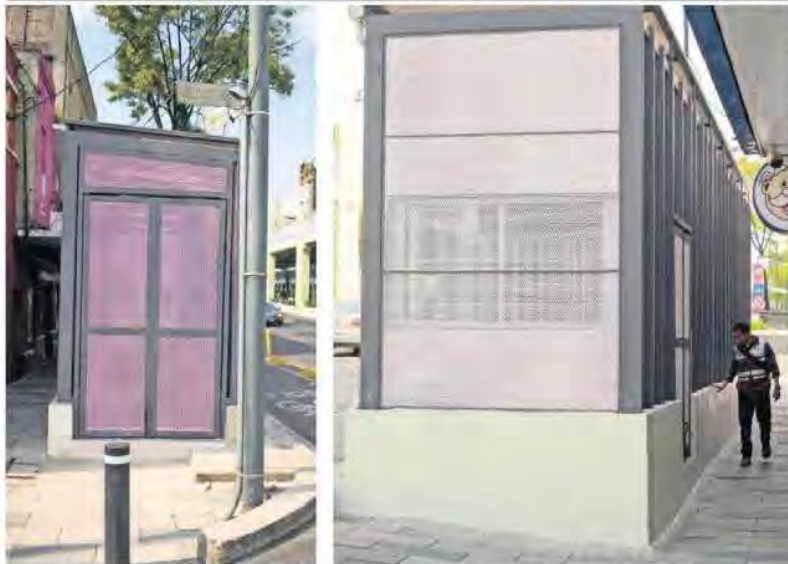
Los trabajos en los pasos ubicados en Calzada San Antonio Abad en sus cruces con Lorenzo Boturini y José T. Cuéllar ya concluyeron.
