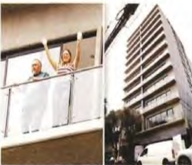
Al edificio que originalmente tenía 36 departamentos le añadieron 18 extra tras la reconstrucción.
