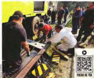
Personal especializado acudió para reincorporar el vagón sobre las vías. Los trabajos tomaron al menos 3 horas.
