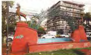
La estructura que sostiene el arco luce grafitis, en tanto que la fuente carece de agua.
