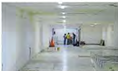
Algunos pasos a desnivel ya se encuentran limpios y con iluminación, aunque aun no se observan trabajos de rehabilitación.
