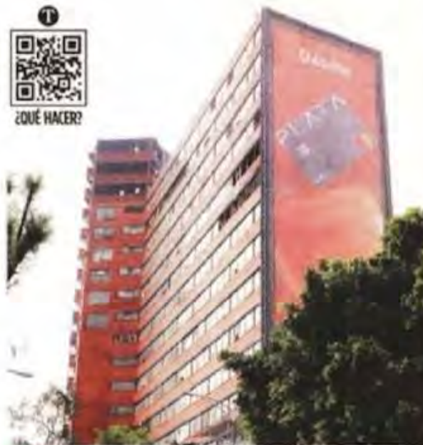
RIESGO. Proprietarios señalan la comisión de delitos dentro de los espacios invadidos, por lo que temen agresiones.
