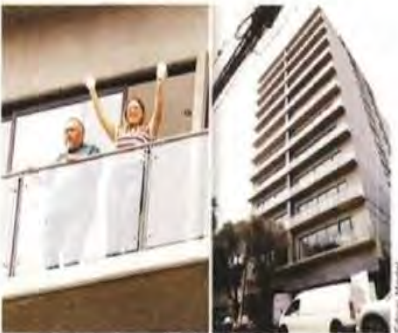
Al edificio que originalmente tenía 36 departamentos le añadieron 18 extra tras la reconstrucción.
