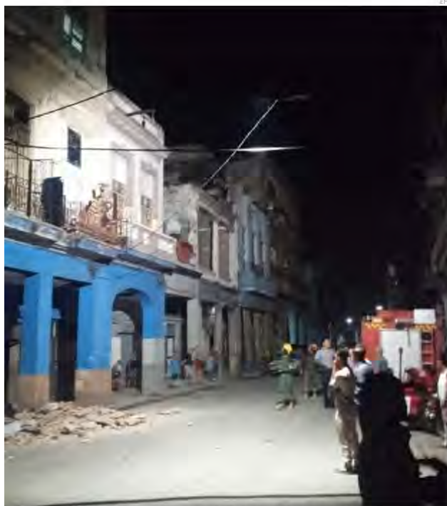
Derrumbe de un edificio multifamiliar en La Habana Vieja en pleno apagón.
