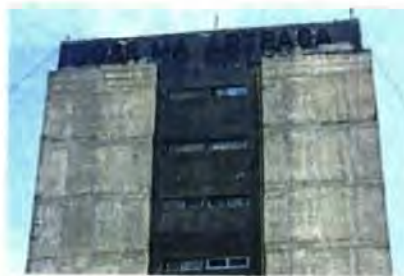
Seis inmuebles con daño estructural grave serán intervenidos por el Gobierno capitalino en Tlatelolco.
