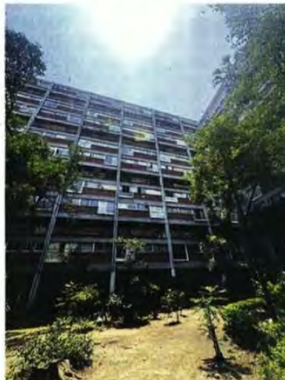
Este multifamiliar fue inaugurado en 1949, por lo que enfrenta deterioro en escaleras, tuberías y paredes.
