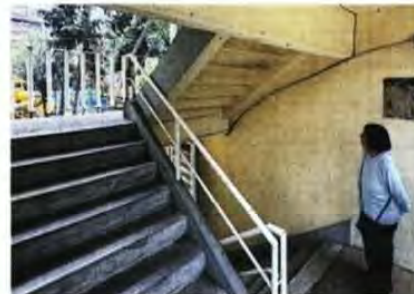
María Teresa Aranda, vecina del CUPA, muestra una de las escaleras que fueron reparadas con el Participativo.
