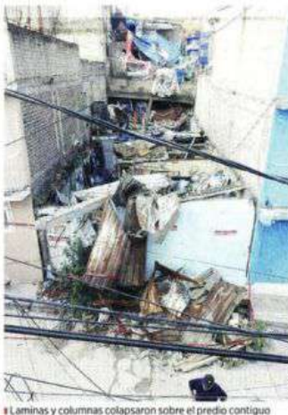
Las láminas y columnas colapsaron sobre el predio contiguo al sitio donde se registró el estallido.
