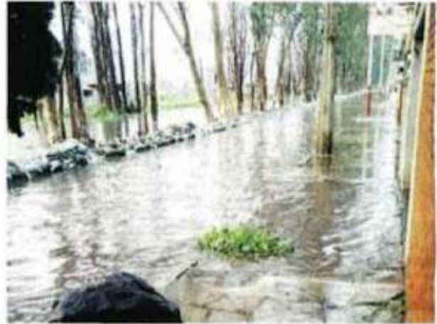
■ Pese a las obras, el Canal Luis Delgado quedó desbordado tras las lluvias del jueves y viernes en calles de La Conchita.
