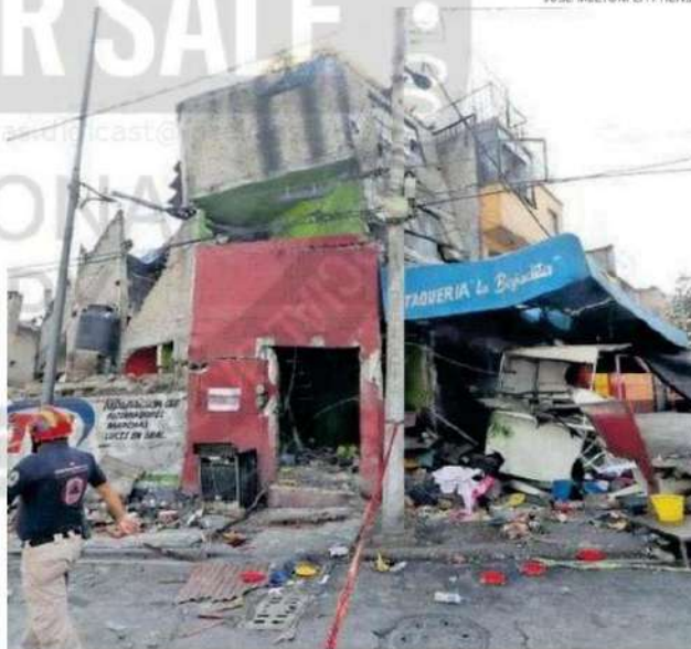
El estallido provocó el derrumbe parcial de un inmueble
