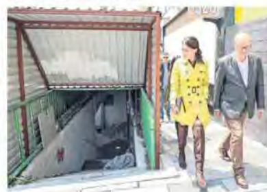
En el paso a desnivel ubicado en Calzada San Antonio Abad y Gutiérrez Nájera continúan las obras de rehabilitación.
