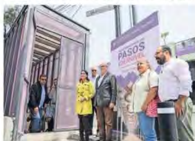
En Lorenzo Boturini también fue necesario colocar una nueva estructura metálica en forma de marco para reforzar los pasos.
