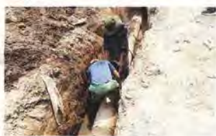
La duración de las labores depende del tamaño de la tubería que se haya dañado.
