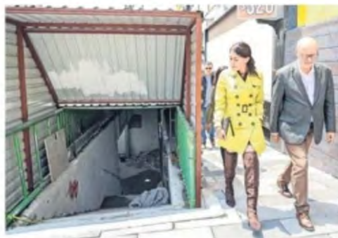
En el paso a desnivel ubicado en Calzada San Antonio Abad y Gutiérrez Najera continúan las obras de rehabilitación.
