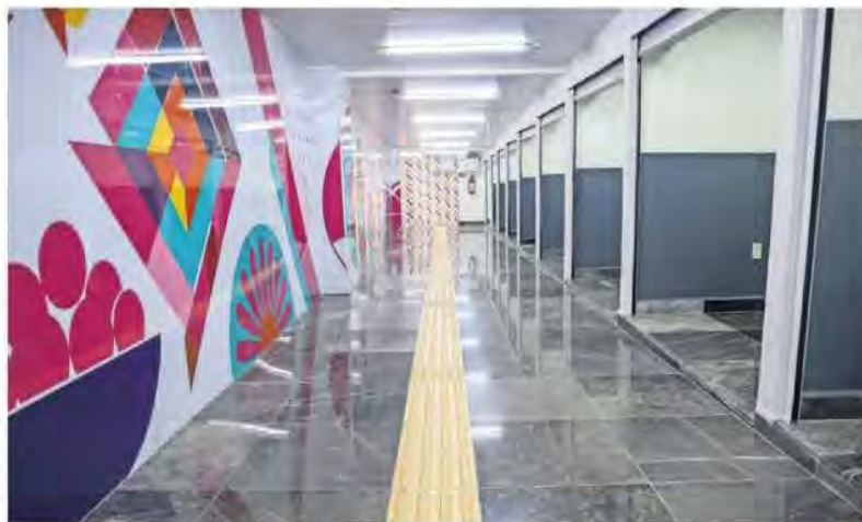
Tanto en el paso a desnivel de Juan A. Mateos con Calzada San Antonio Abad, como en José T. Cuéllar y Lorenzo Boturini hay nuevos pisos, iluminación, acabados y cubiertas en las zonas de acceso, además de cortinas para los locales comerciales y módulos de seguridad.
