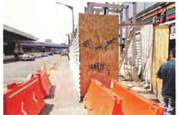
■ Ante las inundaciones frecuentes, se requieren trabajos para renovar el sistema de bombeo que expulsa agua.
