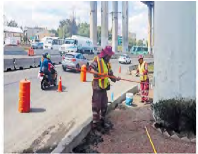
Reparación de la avenida Concordia sobre calzada Ignacio Zaragoza.
