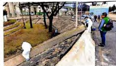
Algunas curvas son más estrechas, por lo que el conductor pudo haber perdido el control de la pipa e impactarse contra el muro, estimó personal de la Secretaría de las Salidas.
