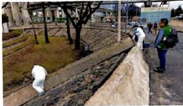
Algunas curvas son más estrechas, por lo que el conductor pudo haber perdido el control de la pipa e impactarse contra el muro, estimó personal de la Secretaría de Obras.
