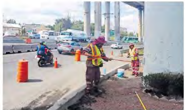
Reparación de la avenida Concordia sobre calzada Ignacio Zaragoza.
