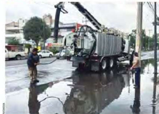
TAREA. Elementos de la Secretaría de Gestión Integral del Agua desazolvaban una coladera para liberar los niveles de agua en Calzada del Hueso y Sauzales, colonia Granjas Coapa, alcaldía Tlalpan.
