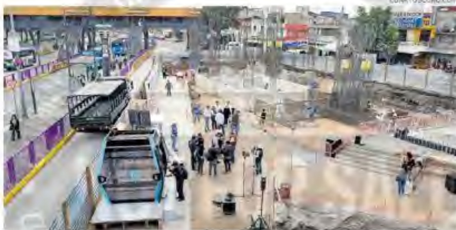
Avance de la construcción de la línea.
