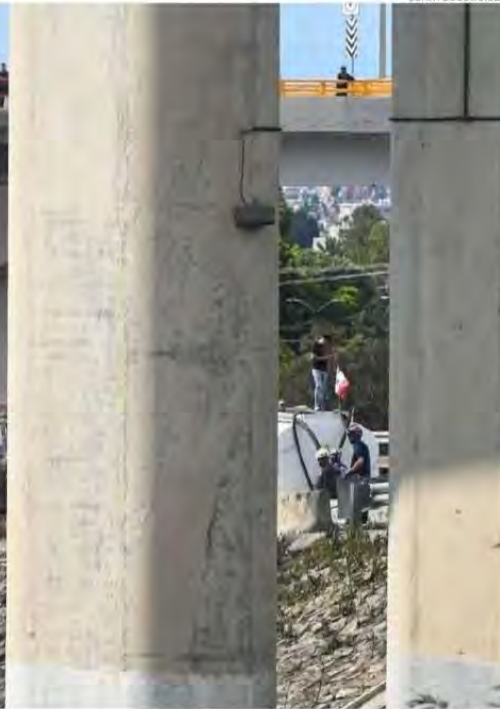
Explosión de pipa en puente La Concordia, Iztapalapa, el 10 de septiembre de 2025.
