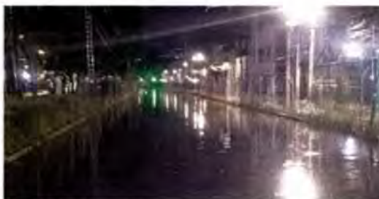
■ Usuarios del servicio acusan que la falta de desagües genera charcos que dificultan el paso.
