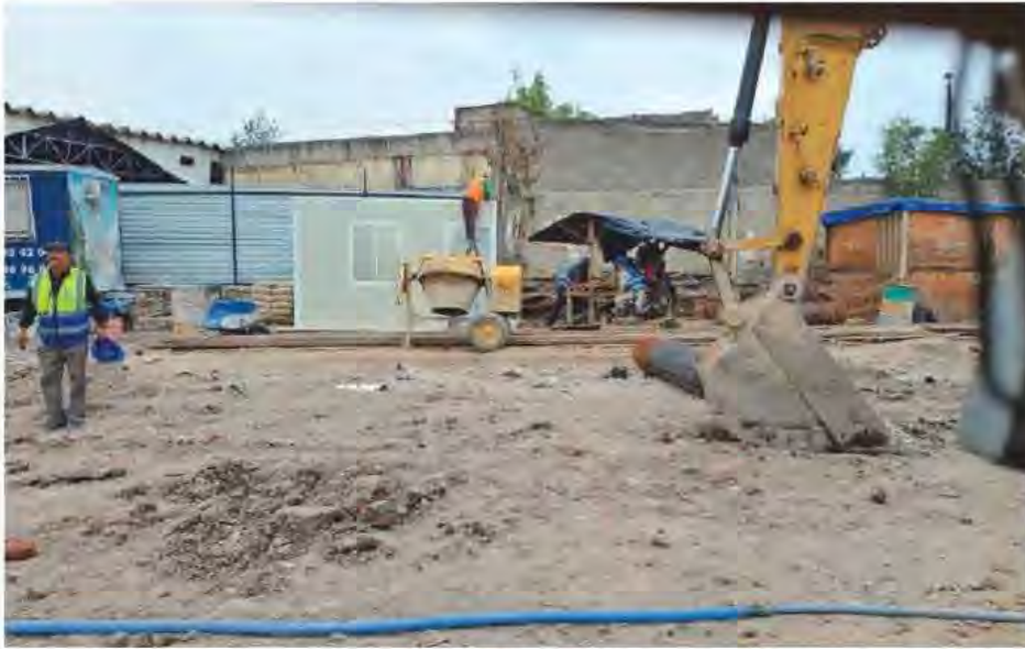
La construcción en avenida Paseo de la Reforma 159, alcaldía Cuauhtémoc.
