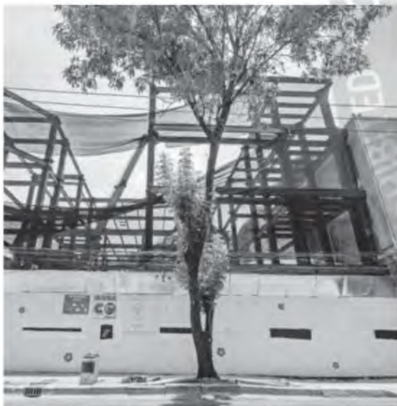
En este sitio se construye un edificio de ocho pisos
