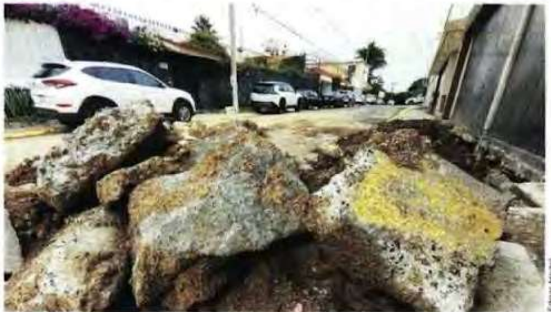
■ Pedazos de concreto, que antes conformaban la banqueta, quedaron sobre la vialidad.
