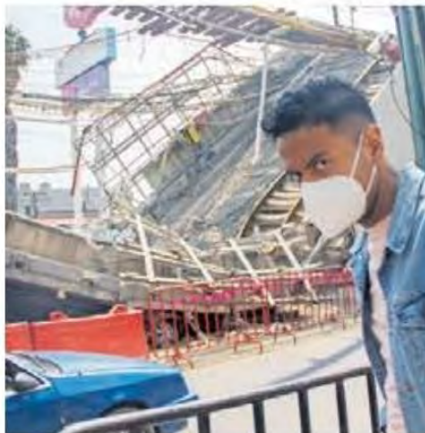
La L-12 colapsó el 3 de mayo de 2021.
