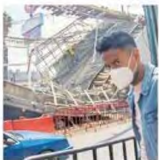
La L-12 colapsó el 3 de mayo de 2021
