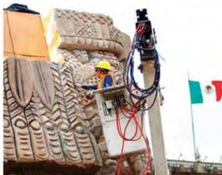
En el Zócalo capitalino, un trabajador en una grúa trabaja en la instalación de la escultura monumental de Tlaltecuhli, diosa de la Tierra.
