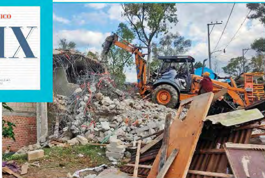
● PROTECCIÓN. Se removieron 184 metros cúbicos de residuos para prevenir afectaciones.
