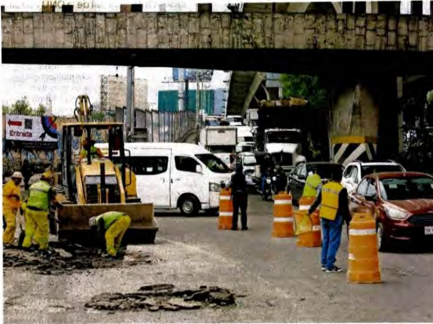
Los horarios de bacheo en Periférico Norte se dividen de 10:00 a 13:00 y de 14:00 a 17:00 horas, cuando se registra menor flujo vehicular, de acuerdo con la Junta de Caminos del Estado de México.
