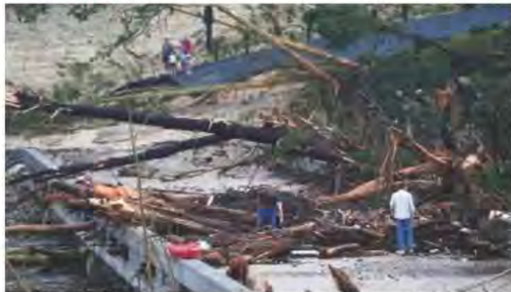
ESCOMBROS EN UN PUENTE sobre el río Guadalupe, tras las inundaciones del 5 de julio.
