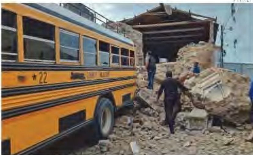
Daños causados en viviendas colapsadas en Santa María de Jesús, Guatemala, tras el sismo de este miércoles.
