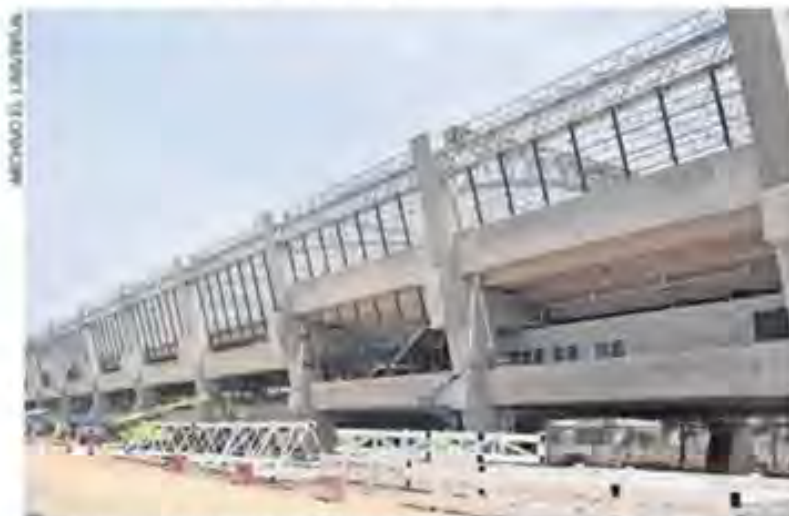
En el tramo de Santa Fe a Observatorio se instalan señalizaciones y sistemas de control y se hacen pruebas de trenes: SICT.
