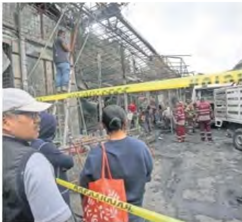
Escombros de la Plaza del Estudiante, luego del incendio registrado la mañana de este martes.
