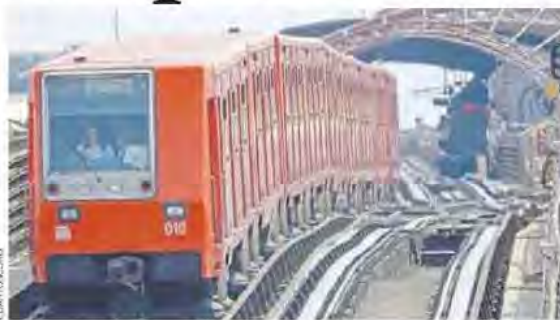
Van a llevarse a cabo varias tareas de mejora en el tramo elevado.
