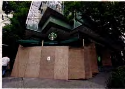
■ En Calle Amsterdam, el Starbucks que había resultado con daños comenzó a operar tras una mampara.
