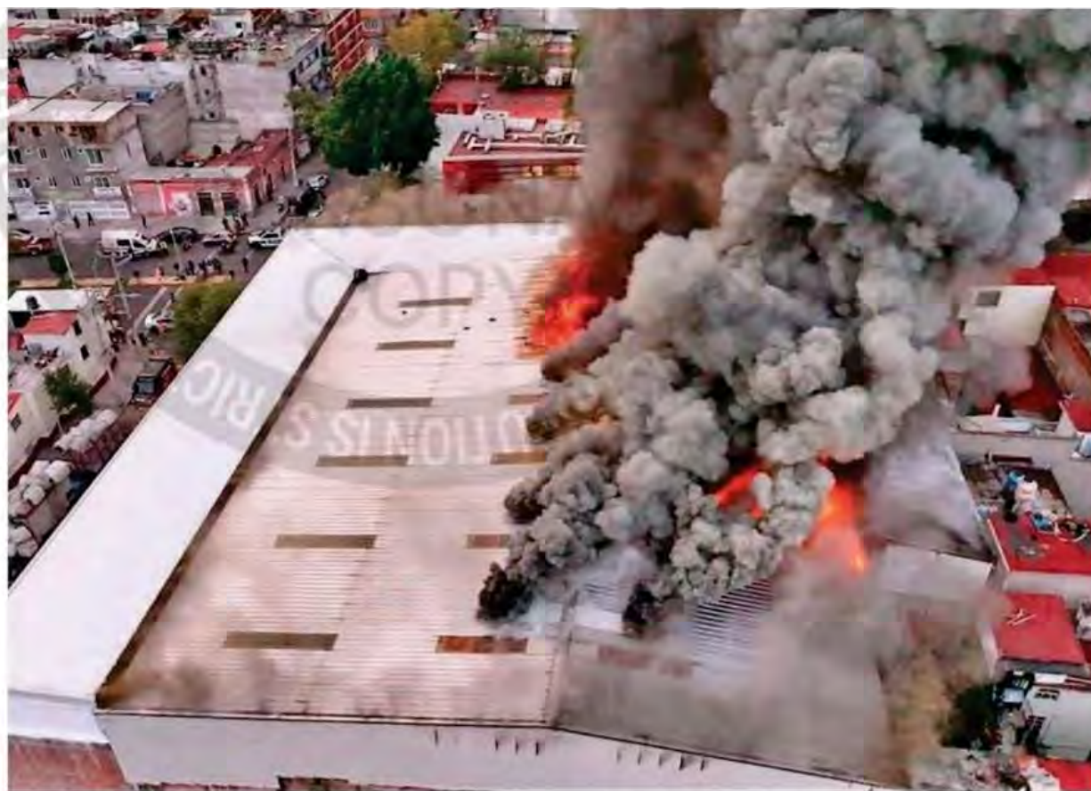
Las llamas consumieron un inmueble de cinco mil metros cuadrados, recién remodelado, para funcionar como bodega
