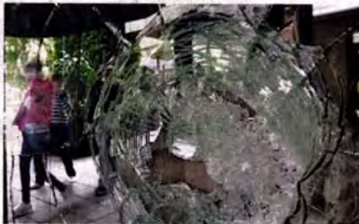
■ Ayer, establecimientos cambiaban los ventanales de vidrio y madera.
