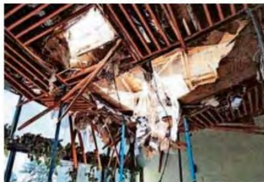
Ahora no solo es el daño a la pérgola sino debido a las lluvias ahora se han generado filtraciones y más daños al penthouse
